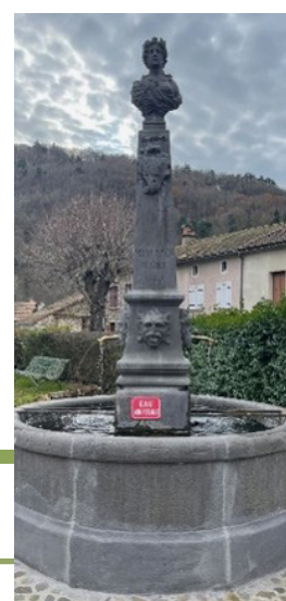
La fontaine après travaux
